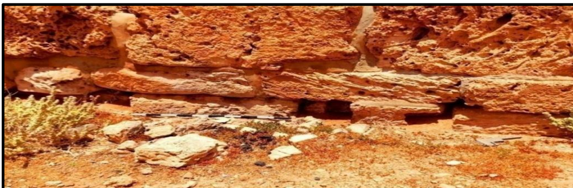
الشكل رقم (2) . توضيح الصورة الآثار المباشرة للسيول والانجراف المائي على القاعدة الإنشائية للمسرح . تصوير الباحث .
