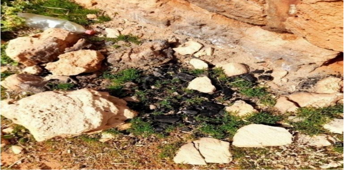
الشكل رقم (6). تظهر الصورة السواد الفحمي المتمركز في الصورة أثر إشعال النار مباشرة عند قاعدة الجدار الأثري. هذه الحرارة المباشرة والعالية تتسبب في حدوث صدمة حرارية للحجر الجيري، مما يؤدي إلى
